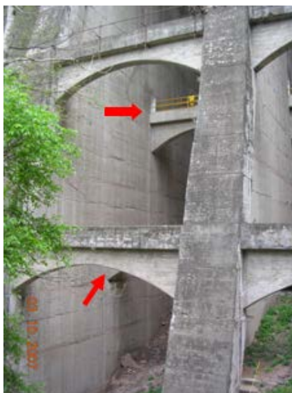
Figura 6. Bocas de entrada al vano 15-14, por las pasarelas superior e inferior (foto de la izquierda) y vista de una de ellas (foto de la derecha) del embalse de Escaba.
